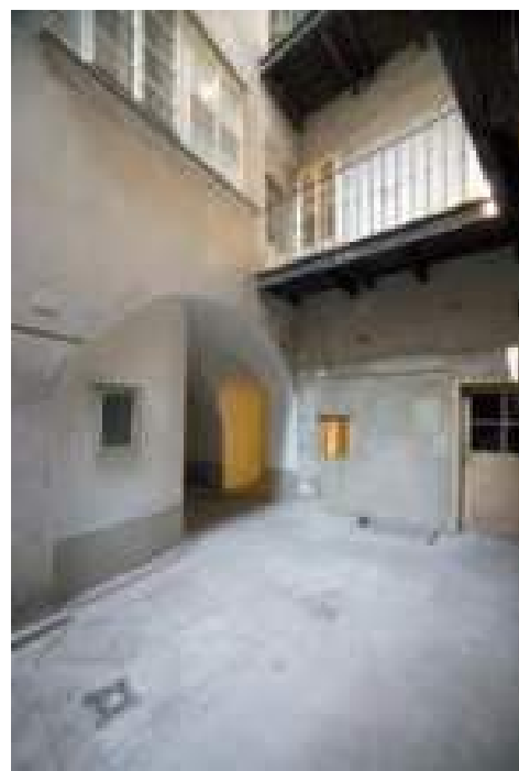
Schnittstellen der Sanierung im Pawlatschenhof
